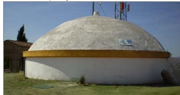
Vista del depósito general de abastecimiento a la localidad.
