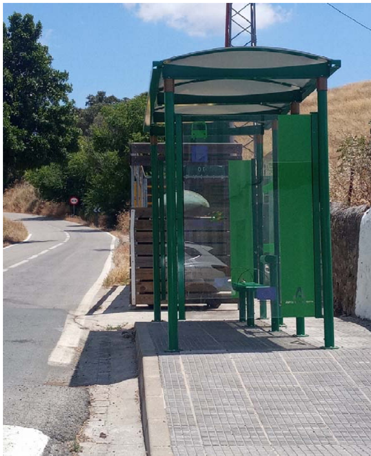
Foto: Parada de autobuses inaccesibles desde el acerado.
