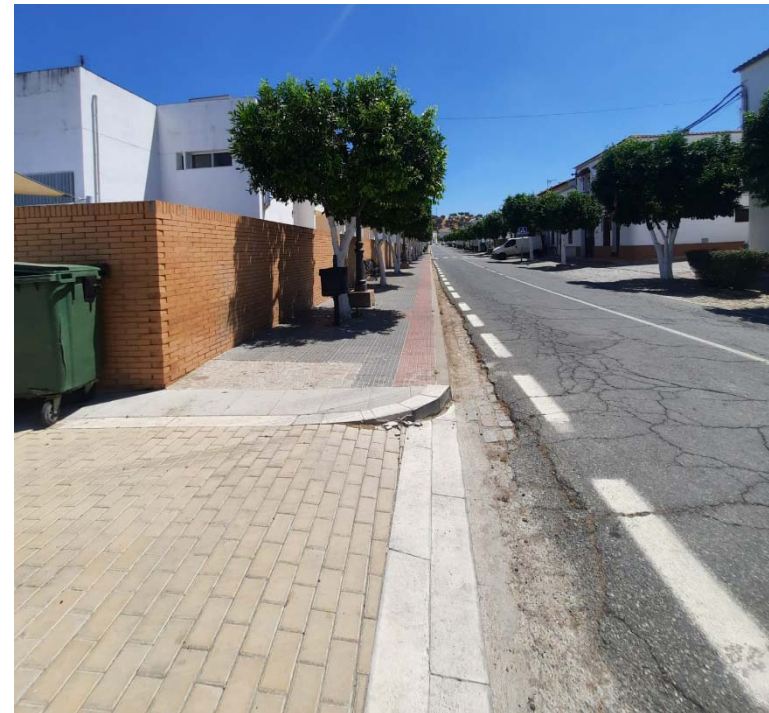
Foto: Las dimensiones y la presencia de obstáculos dificulta el paso por las aceras.
